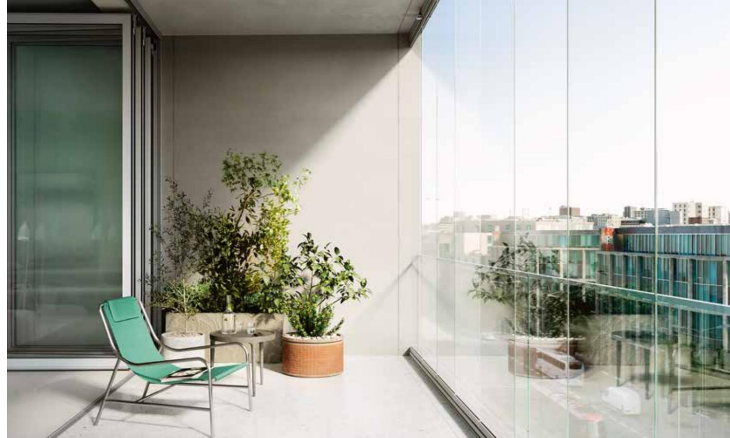
Die ideale Kombination für einen geschützten Balkon mit modifizierbarem Mikroklima: Die Glas-Faltwand stellt die flexible Grenze zum Innenraum dar, während die Schiebe-Dreh-Verglasung die Einflüsse von außen reguliert.
